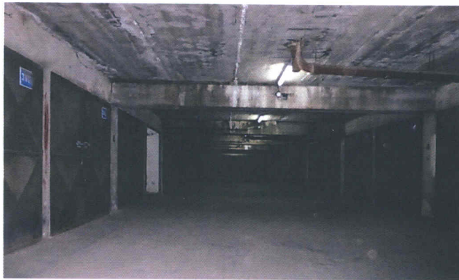
Obr. 1 - Pohľad na vnútorný trakt garáží
